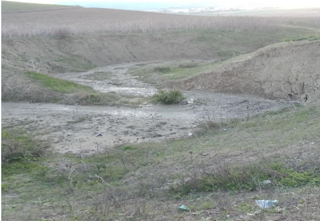
Figure 24 : Érosion par sapement des berges du cours d'eau de l'Oued Joumouaa (FARTAS, 2019).
