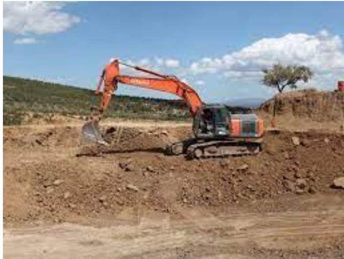
Figure 1. 14: Extraction de l'argile à l'aide d'une pelle mécanique [42].
