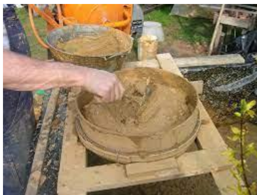
Figure 1. 15: Préparation de l'argile [42].
