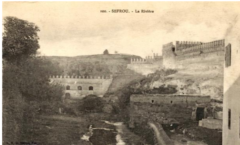
Photographie I.2 : Le lit de l'Oued Agay avant son entrée au Mellah, avec au centre le vieux rempart à ouvertures pour laisser passer l'eau 1950, (Source : Fès éternelle et mystérieuse 2017)
