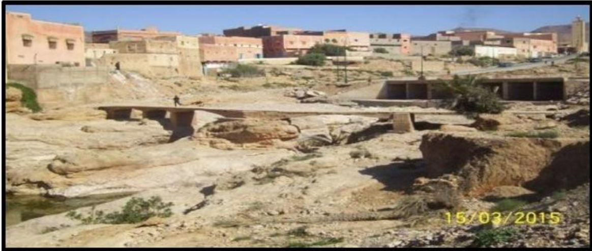
Photographie I-9 : L'extension de l'habitat à côté du lit de l'oued Ifrane à Ifrane Anti-Atlas central(source : ATBIR, 2019)
