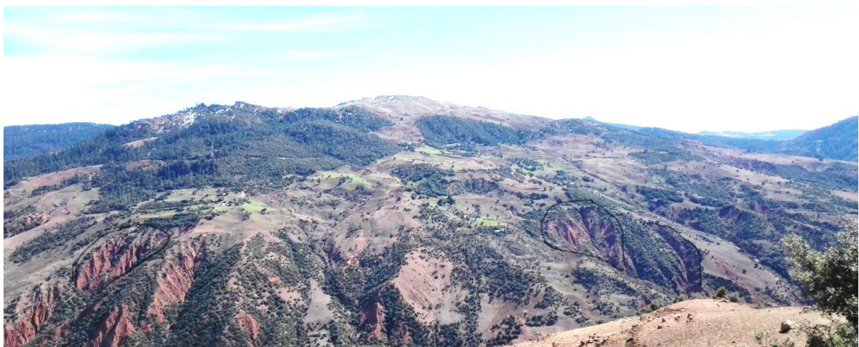
Figure VI. 31 : photo de la zone d'étude montrant des traces de glissements de terrain
