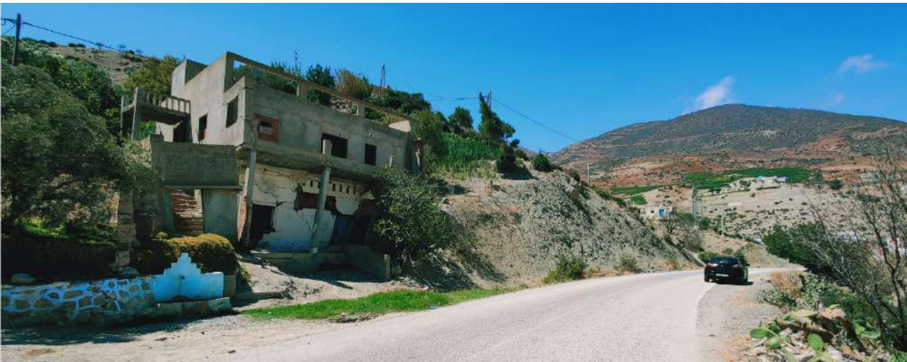
Figure 5 : des maisons s'effondrent à cause de l'érosion hydrique des sols et des glissements de terrain
