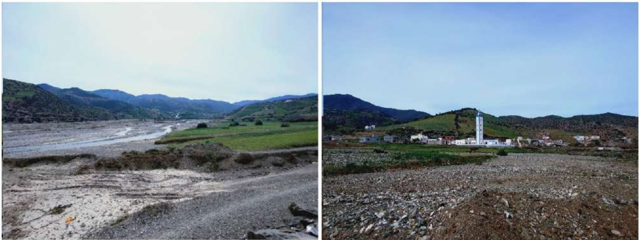
Figure 2 : Erosion en nappe (photo d'oued Amtar du jeudi 9 mars 2023)
