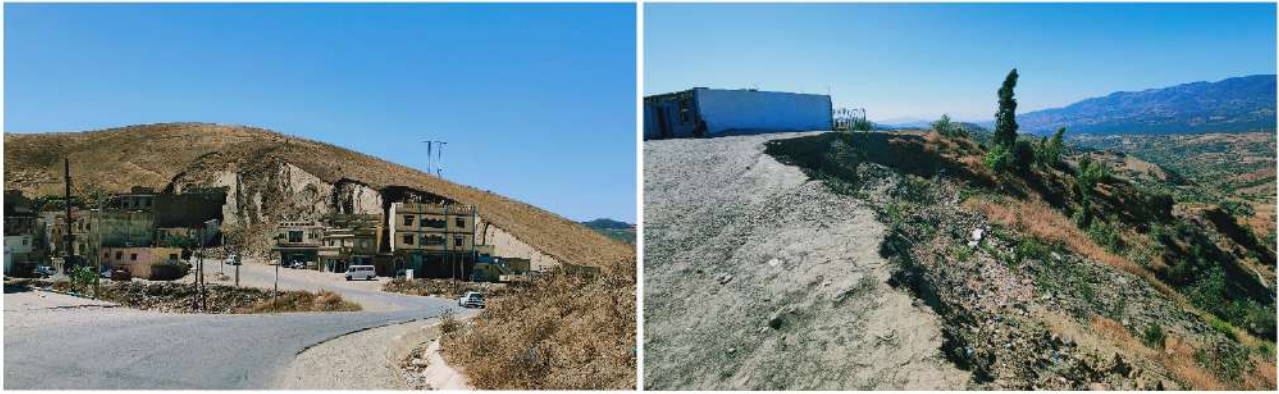
Figure 1 : Construction en amont du talus.
