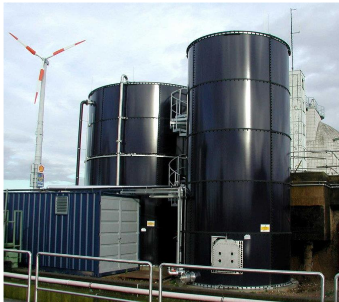
Figure 47 : Exemple de digesteur pilote (SBR anaérobie)
