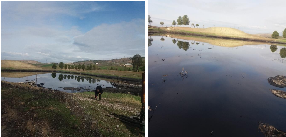
Figure 2 : Bassin d'évaporation naturelle des margines dans les environs de Fès
