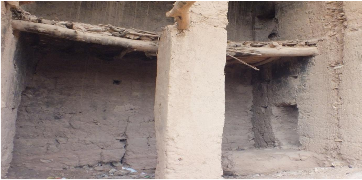
تصوير شخصي بتاريخ 21 غشت 2017م، بملاح أسفالو، بتنغير، لسارية أرضية un pilier شيدت من الطابق الأرضي الأول إلى الطابق العلوي الثالث وعلما مجموعة من الأعمدة الخشبية لتوضع السقف الأول.
