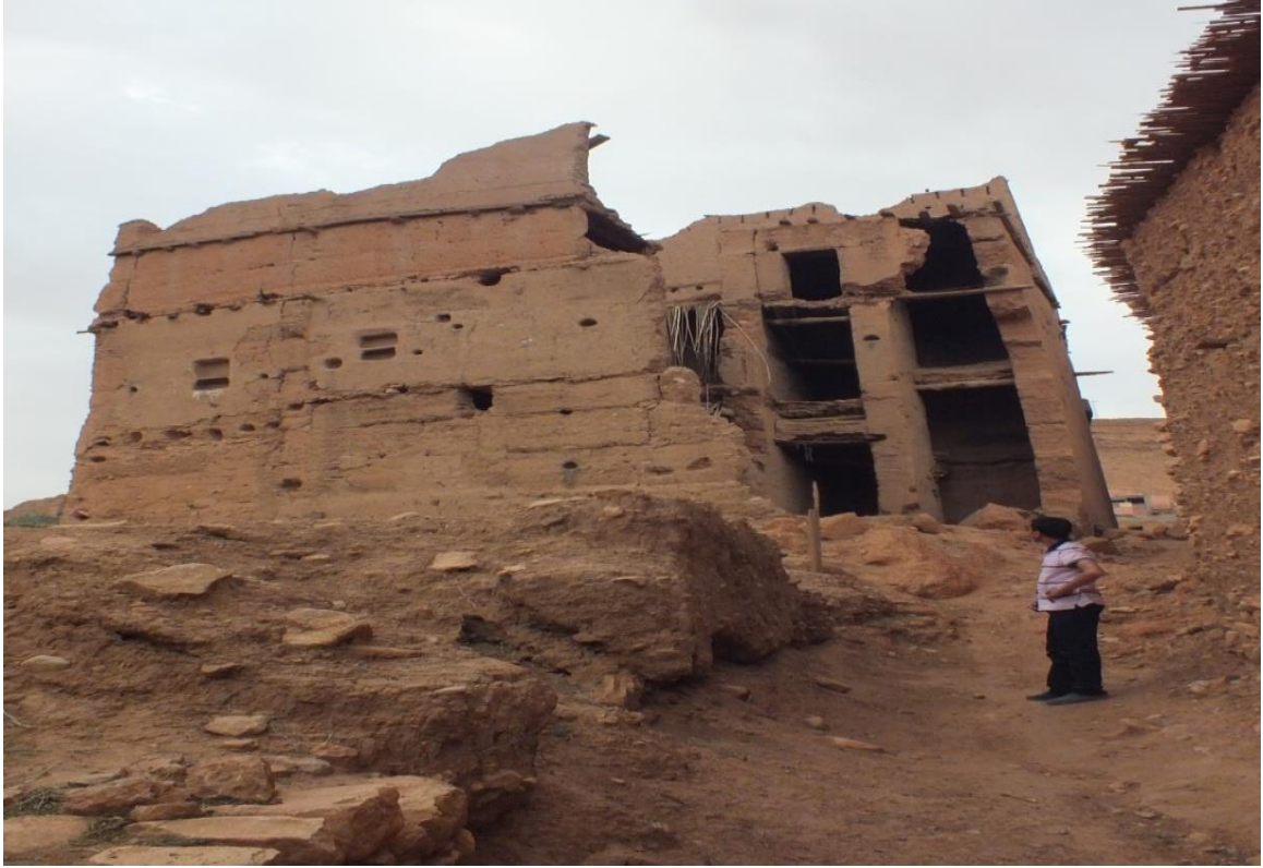
صورة للباحث بجانب ملاح يهود أسفألو بعدما هدمت جدرانه وسقوفه، بفعل تأثير العوامل الطبيعية.
