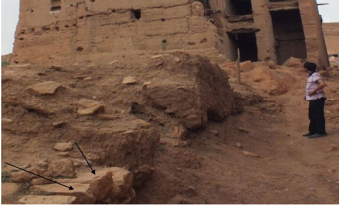
تصوير شخصي لملاح أسفالو، تظهر بجلاء استعمال اليهود الحجر في الأساس والتراب في بناء الجدران، كما تشير إلى ذلك الأسهم
