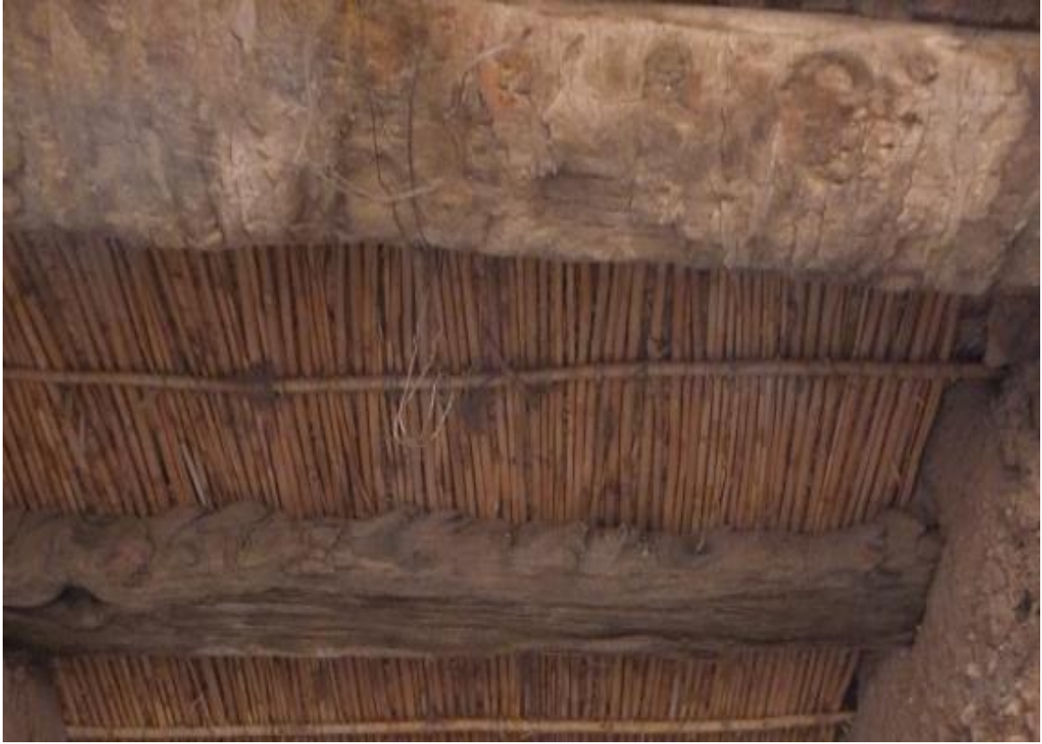
سقف قصر أمازيغي فيه الأعمدة الخشبية والقصب
