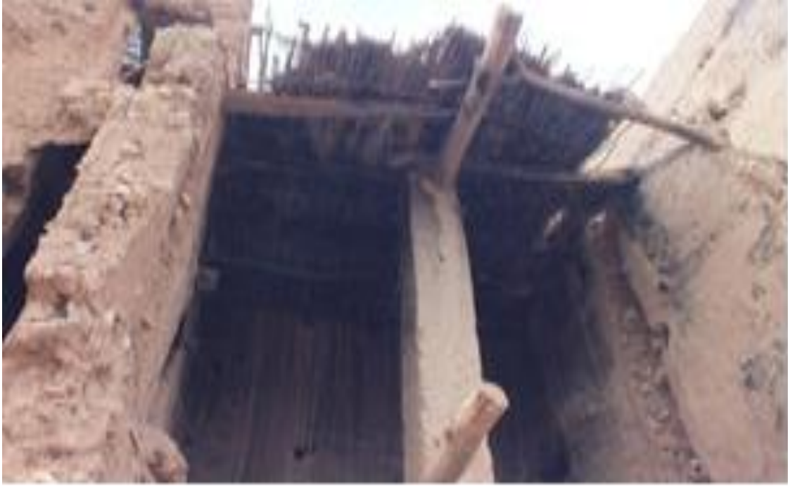
سقف ملاح يهود أسفالو وطريقة سقفه بالقصب وجريد النخل.
