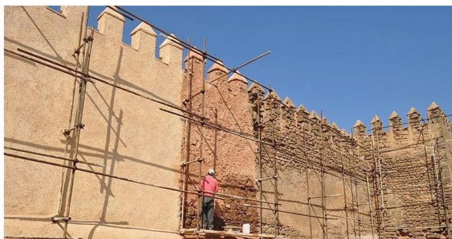
Figure 13 : Tranche de la muraille Al Mohades (Bab Chaâfa) de la ville de Salé en phase de restauration.
