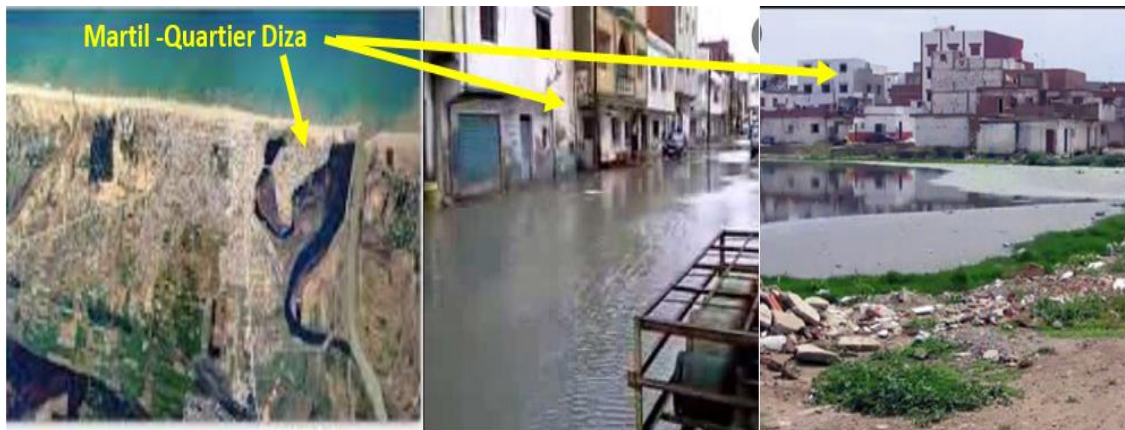
Photo 6, a- Situation du Quartier Diza (Martil) ; b- Inondation des ruelles ; c- Précarité du quartier (urbanisation anarchique)
