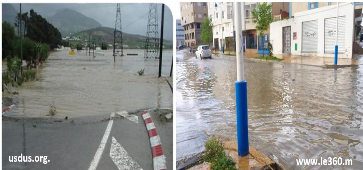
Photo 8 : Inondations du réseau routier à Martil lors de fortes intempéries
