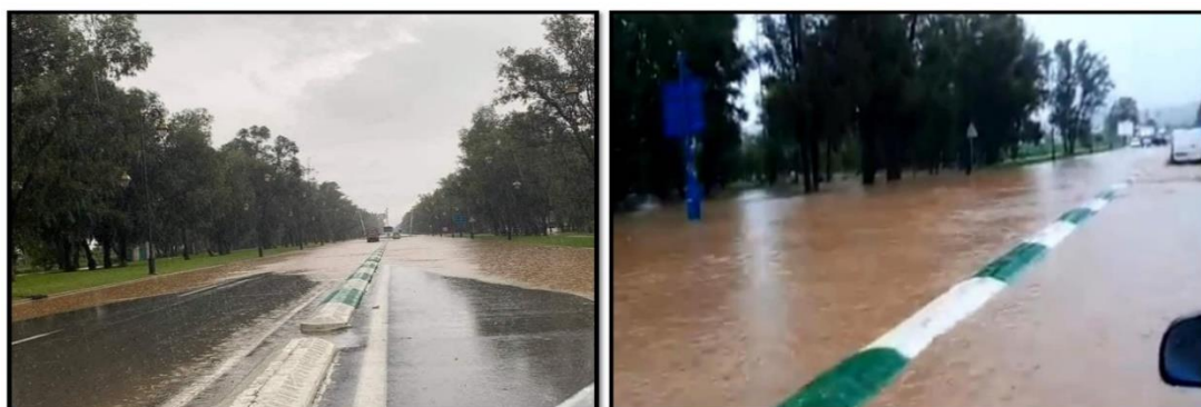
Photo 3 : Photos illustrant l’impact d’inondation sur l’axe de la route nationale R16 - R13
