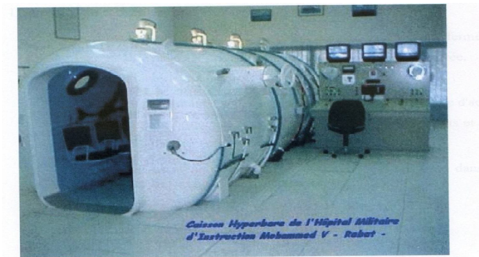
Photo 2 : vue extérieure du caisson de l'HMIMV
