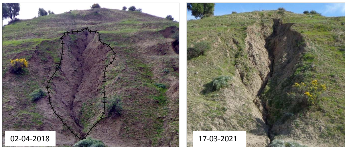
Photos 18. Situation de ravin Jeref en deux périodes de mesures : a (2018) et b (2021)
