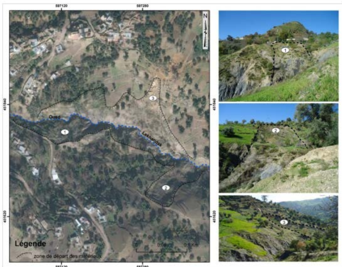
Figure 62. Les glissements au niveau de Douar Jamaa Delem (El-Bouhali, 2016)
