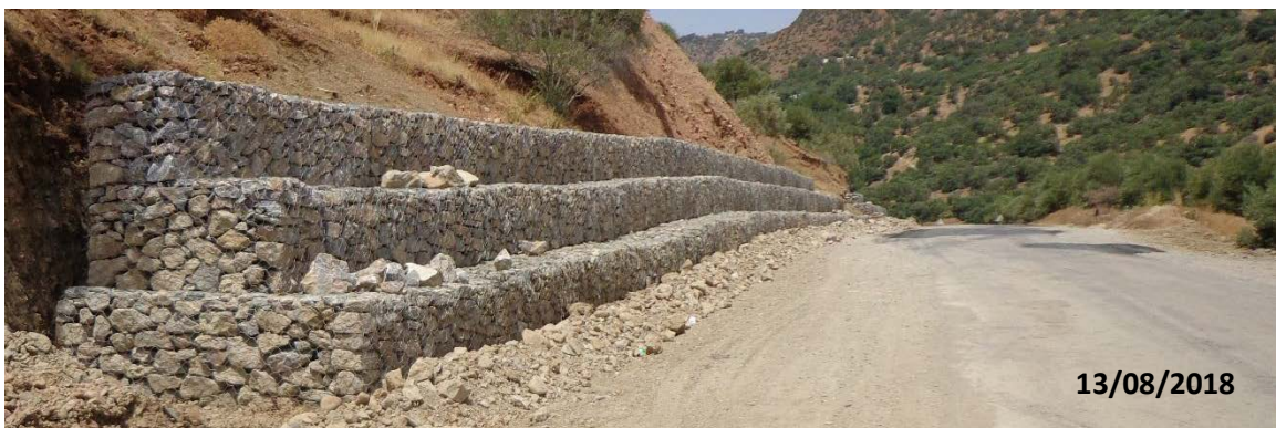
Photos 38. Seuils en gabions dans le cadre d'aménagement de la route régionale 510
