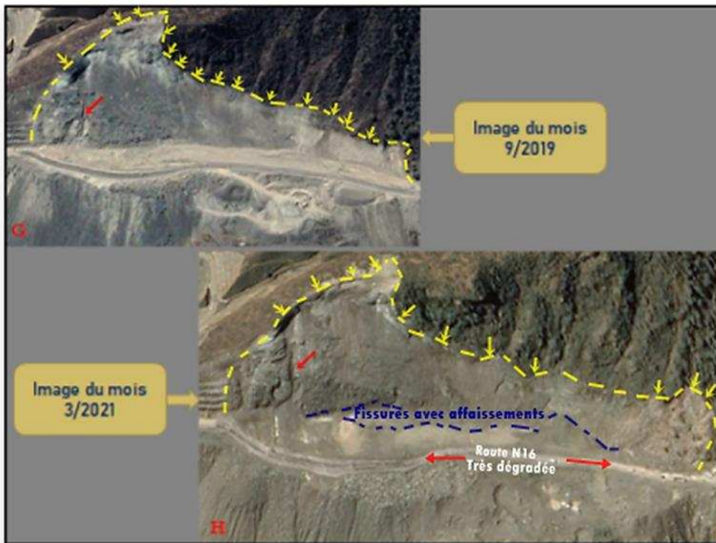
Figure 50 : Images satellitaires de la section S3 durant les mois 9-2019 et 3-2021 (Google Earth) G) Elargissement de la surface de glissement et déviation de la voie. H) Apparition de nouvelles zones instables à l'aval en venant de Oued Laou. Développement des instabilités de la plateforme.
