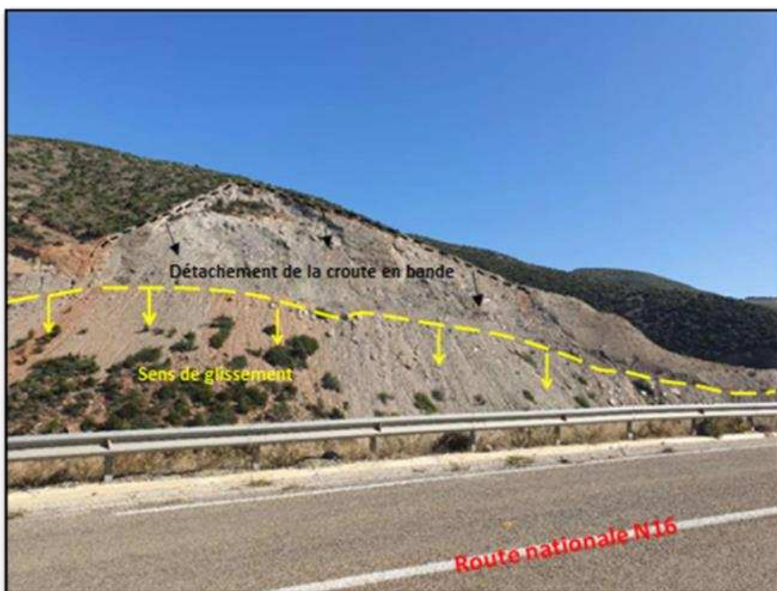
Figure 65 : Exemple de mouvement de masse qui touche les versants de la section S8 (aout 2022) Les bandes de la croûte qui se détachent et les débris de la roche altérée et décompressée forment des grands volumes de colluvions qui glissent suivant la pente du talus
