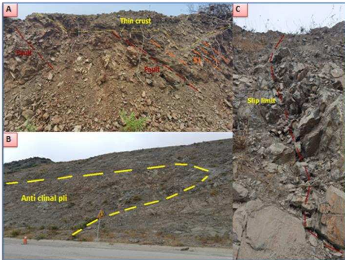
Figure 73 : Déformations et fractures observées dans le talus étudié (aout 2022)
