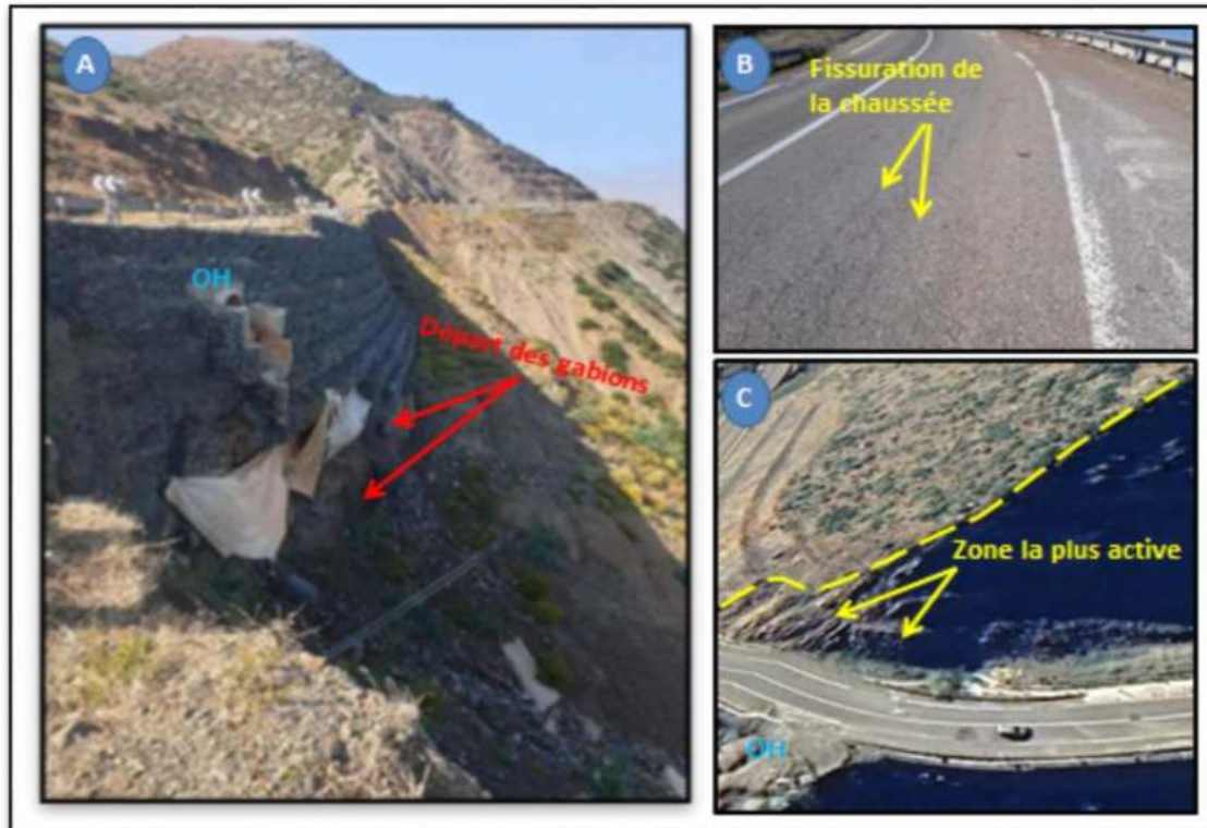
Figure 56 : Etat des lieux de la section S5 (aout 2023)
