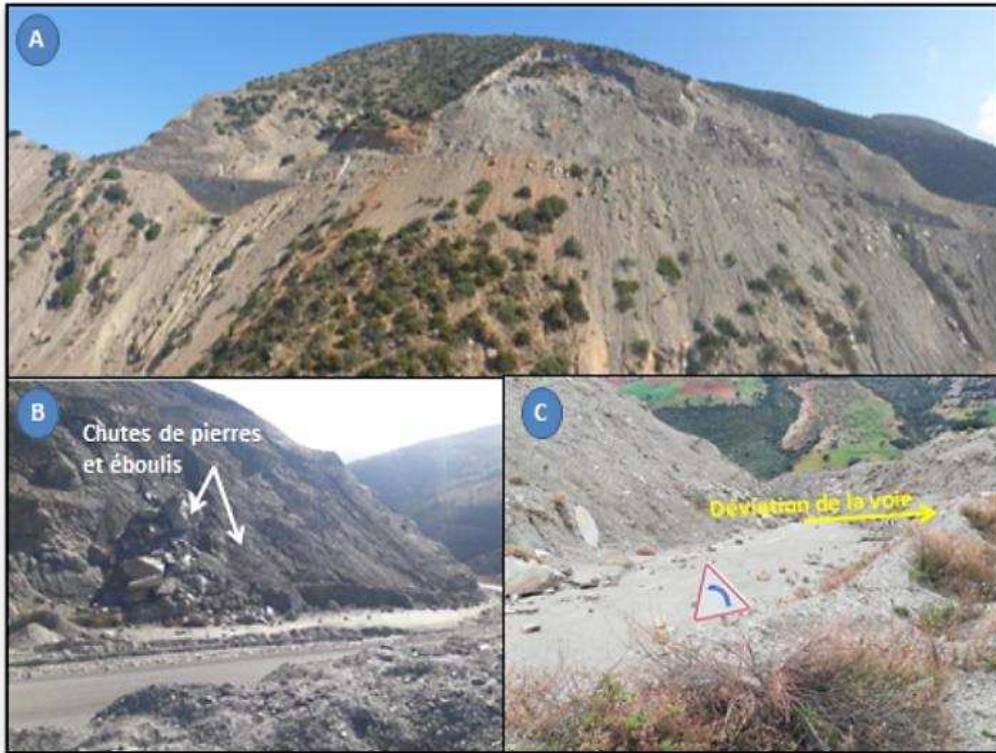
Figure 63 : Etat des lieux de la section S8 dans la zone du PK 190+600 (aout 2022)
