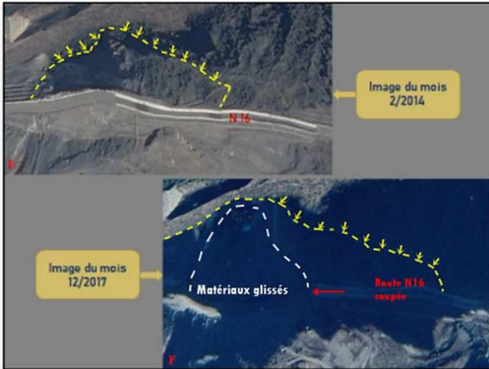
Figure 49 : Images satellitaires de la section S3 durant les mois 2-2014 et 12-2017 (Google Earth) E) Ripage de la route vers le sens de la colline pour éviter le glissement du remblai de la plateforme. F) Effondrement du talus en décembre 2017 au même endroit du glissement de l'année 2011 provoquant le blocage de la circulation
