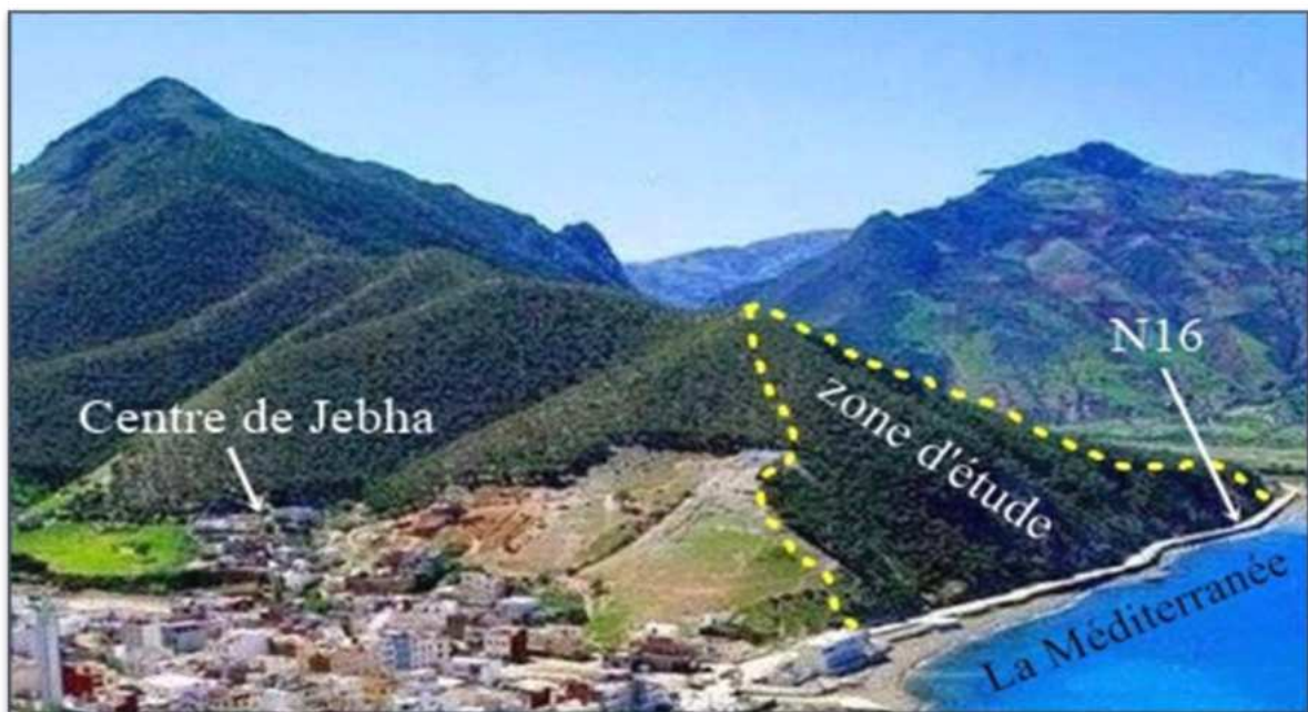
Figure 99 : Photo amateur montrant l'état des lieux avant l'élargissement de la voie et les travaux de déblais et remodelage du talus (2005).
