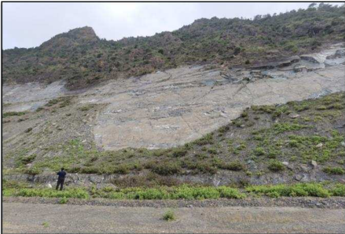
Figure 46 : Vue d'ensemble du versant reflétant l'ampleur de la zone active. Les surfaces de schiste exposées à l'air sont très lisse et provoquent un effet miroir (mars 2023)
