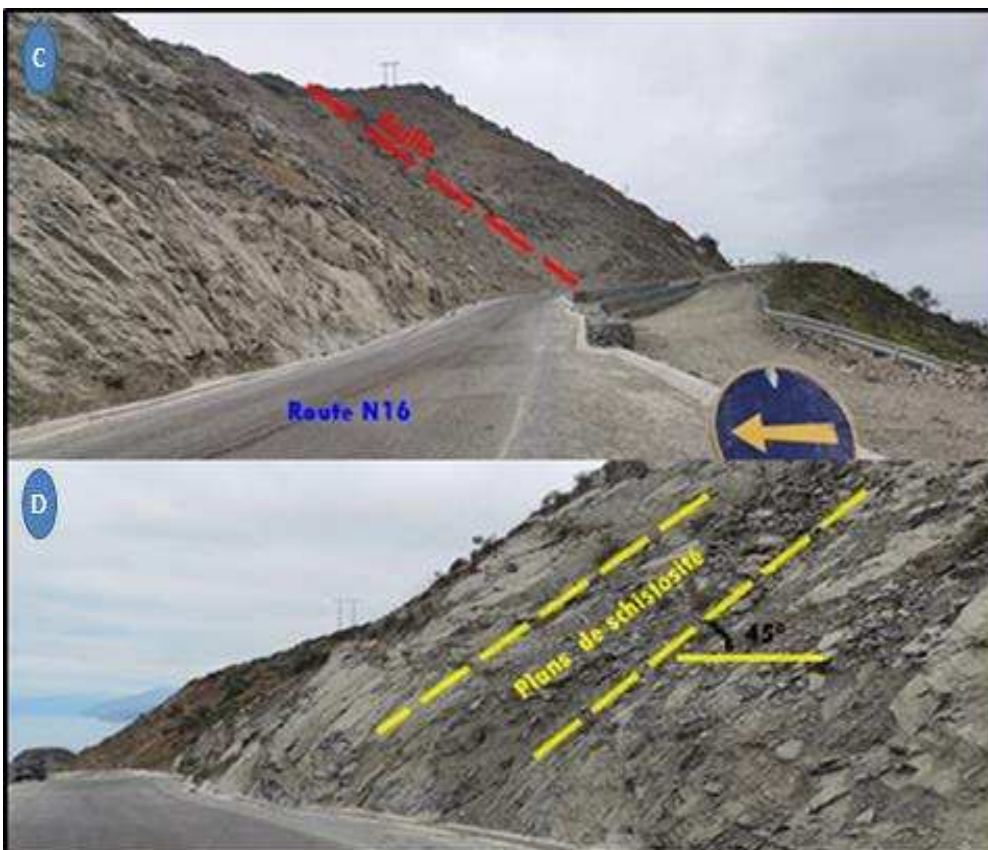
Figure 53 : Repérage de la faille observée sur site (C) et matérialisation des plans de schistosité (D)
