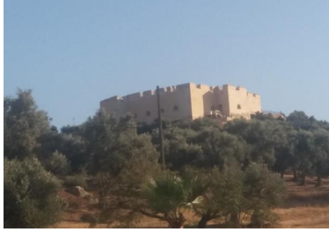
الصورة رقم 10: البرج الجنوبي جنوب المدينة القديمة لفاس
