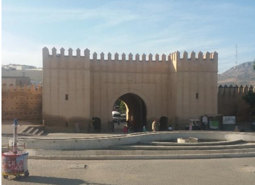
الصورة رقم 12: باب الفتوح بعد عملية الترميم
