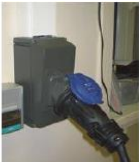
Figure 23. Prise électrique du laser Greenlight
