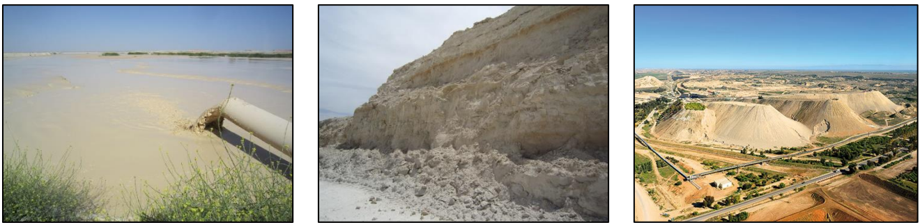
Figure 2: Stockage des déchets miniers de phosphate Khouribga Maroc : photos prises sur site.
