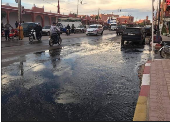
الصورة 6: انفجار احدي قنوات الصرف الصحي بمركز قلعة مكونة
