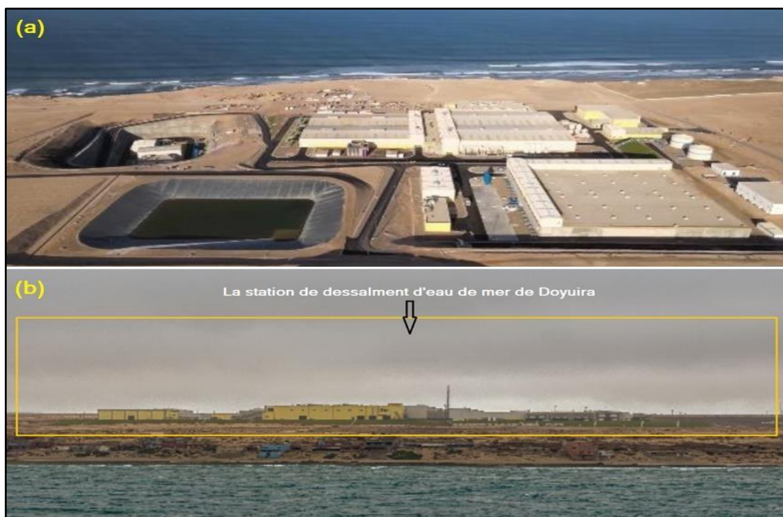
Figure 21: Vue aérienne de la station de dessalement de Douira (a) et photo de la station vue de mer (b).
