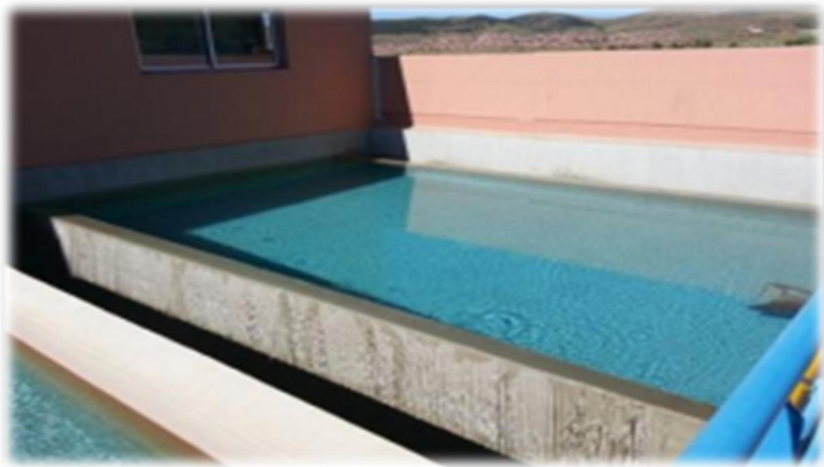
Figure 22: Filtre à sable
