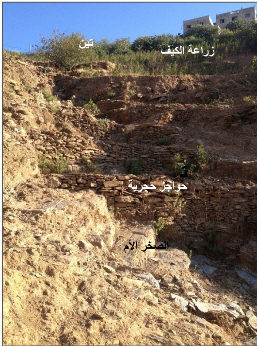
الصورة 52: التدخلات الميكانيكية لمعالجة الخدات
