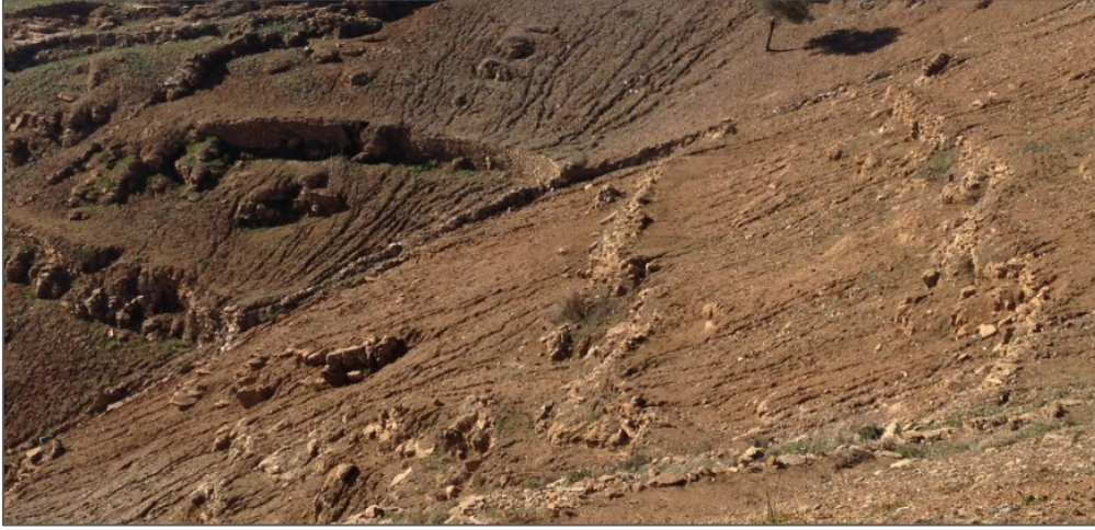
الصورة 51: دكات مدعمة بالحجارة بجماعة بوهودة (وضعية 2017)
