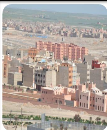
Vue panoramique sur site future quartier Jnane Lkhir
