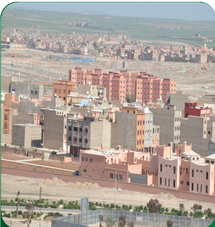
Vue panoramique sur site future quartier jnane lkhir
