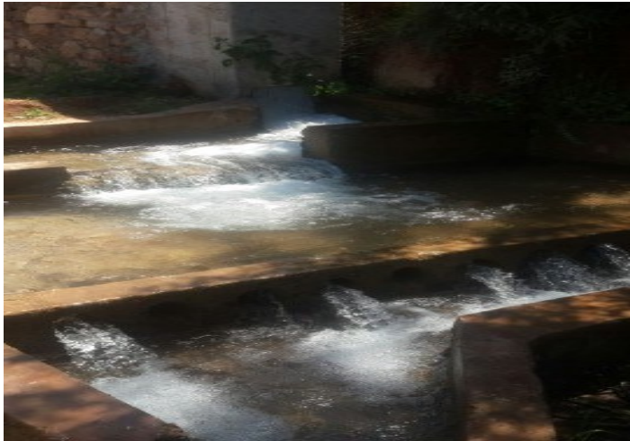
Photo 3 : Aménagement d'une segouia en 12 trous. Chaque trou correspond à un propriétaire qui bénéficie de ces eaux alternativement avec les 11 restants, selon un jour et une durée précise (à Izmouyn).
