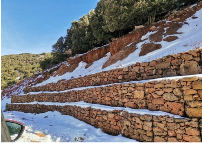
Photo 1: Aménagement des versants par des cordons de pierres (à Tawrirt)
