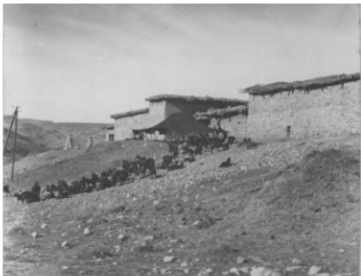
Photo 1 : Une « taddert » construite avec des matériaux locaux dans la région de Naour
