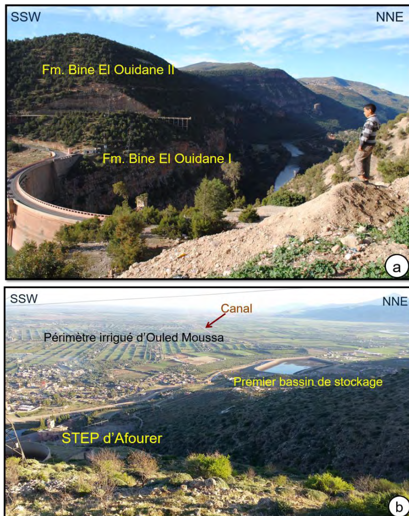
Fig. 20 : a) Vue panoramique sur la digue du barrage Bin El Ouidane ; b) Vue panoramique sur la STEP d'Afourer et la plaine de Tadla.
