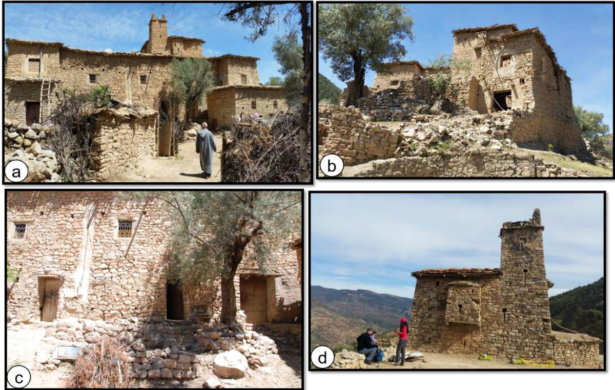
Fig. 85 : a, b et c) Vue sur tout le grenier d'Igaadi ; b) Vue nord du granier; d) Le toit du grenier
