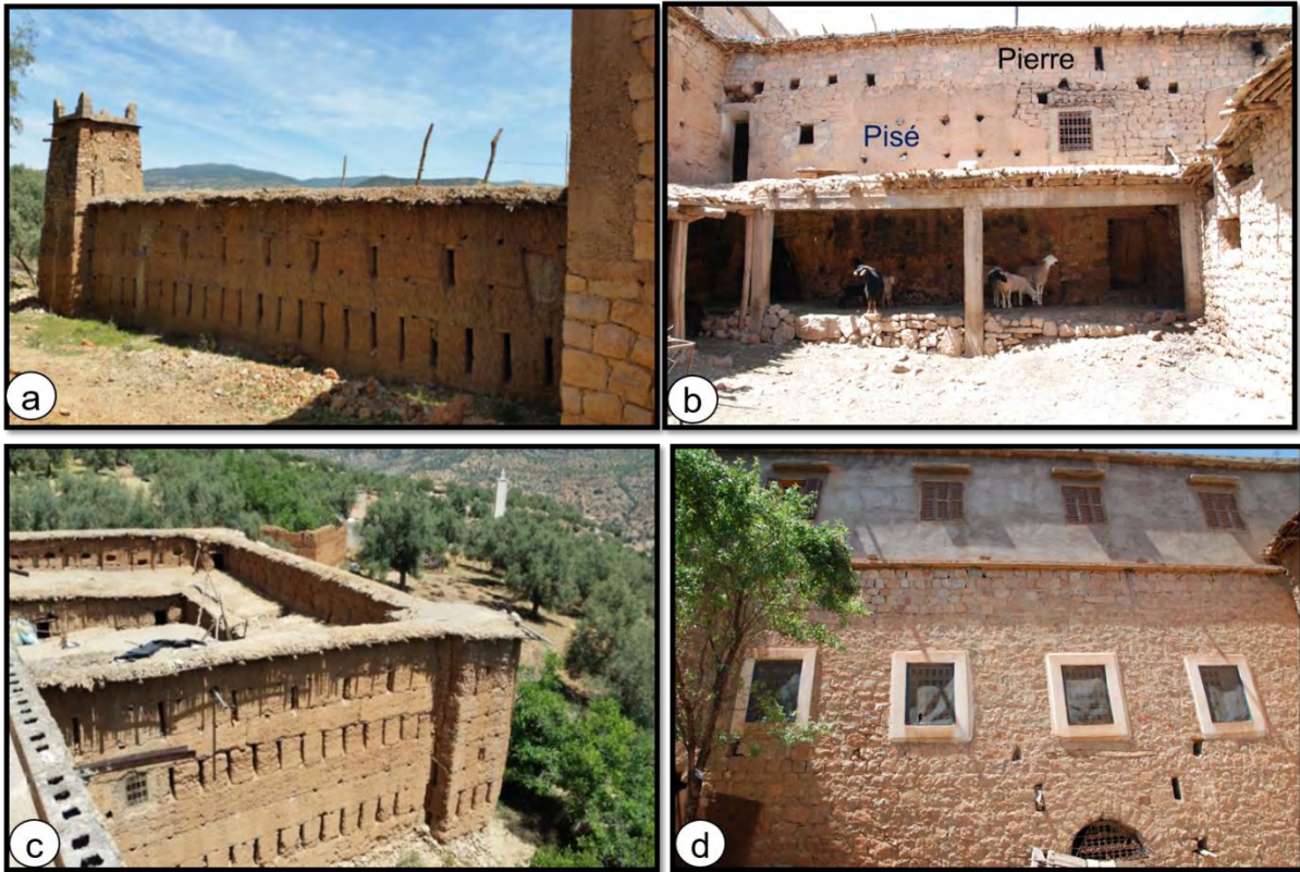
Fig. 84: a et c Vue de panoramique du grenier ; d) Vue de l'intérieur de rez-de-chaussée ; d) Nouvelle construction en pierre et en matériaux modernes
