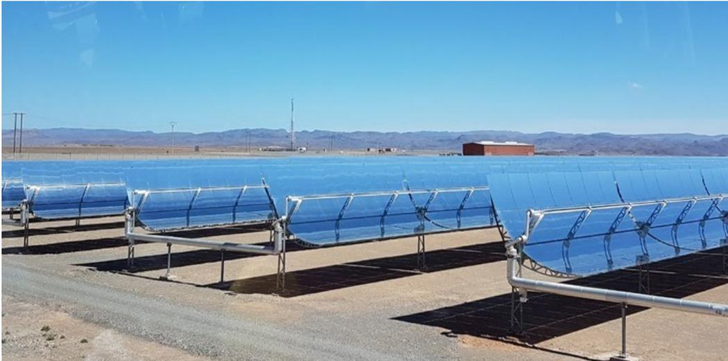
Figure 9: Une partie de la central solaire NOOR, technologie cylindro-parabolique, de Ouarzazate
