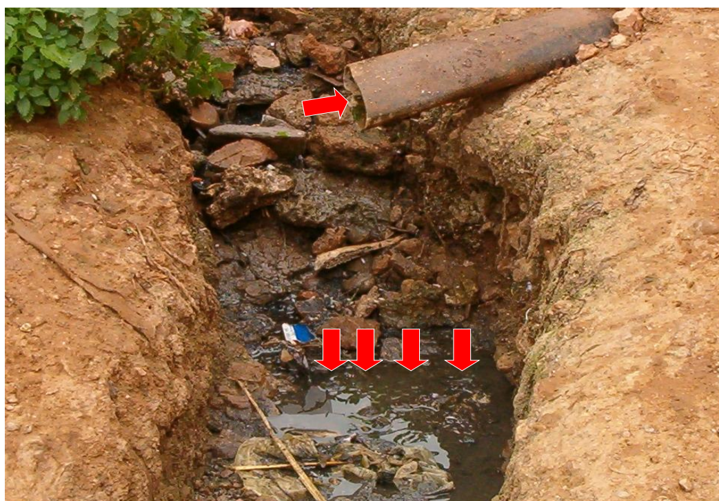
Figure 10 : Un rejet des eaux usées (Photo prise à Foum Jamaà)
