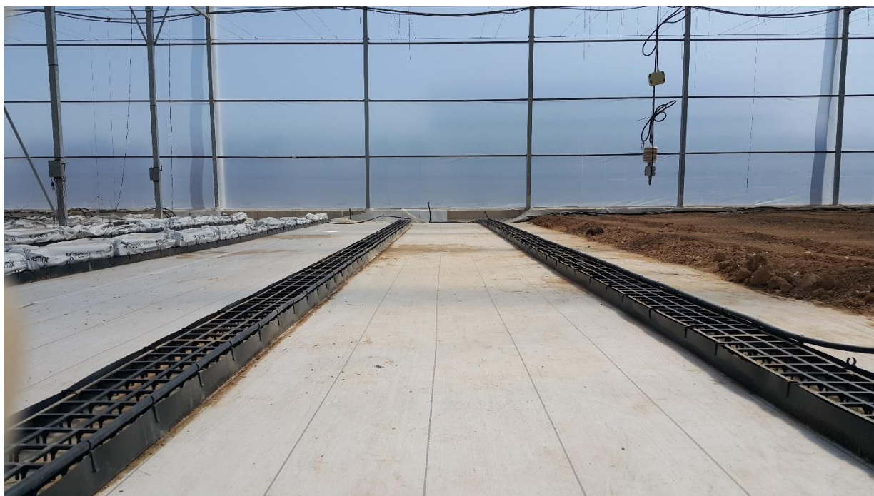
Figure 18: Surface de travail qui est de l'ordre de 13m 2 et de deux lignes.
