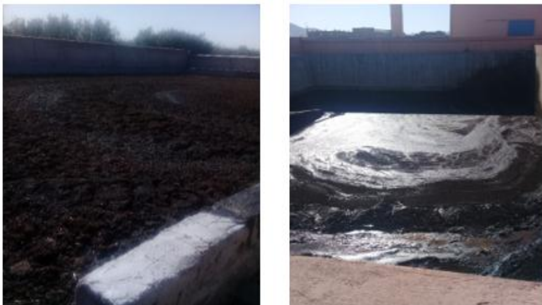
Figure I-5: Bassins de stockage des margines (système biphasique)
