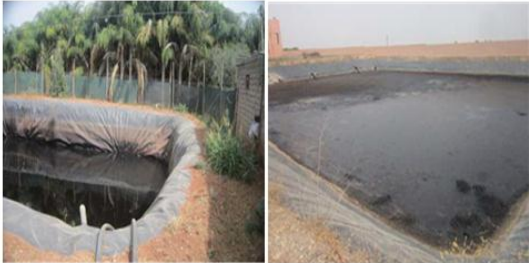
Figure I-2 : Bassins (avec géomembrane) Pour le stockage des margines
