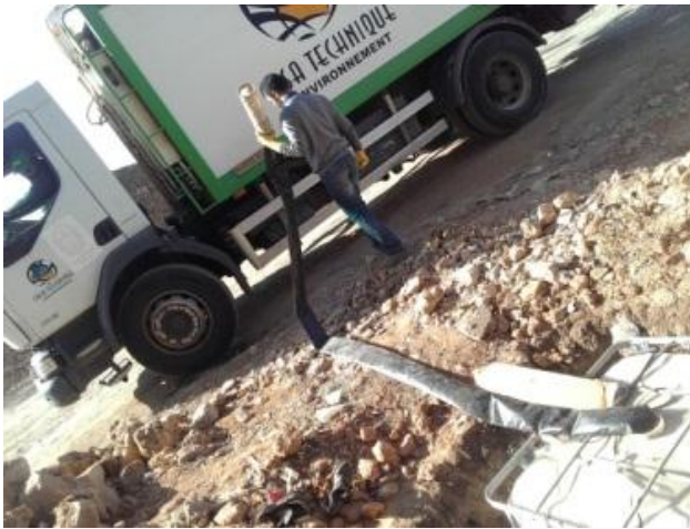
Photo 3 : Récupération et transport de lixiviats
