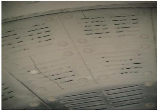
Figure IV.30. Colmatage et plaques cassées de la cloison de sortie
