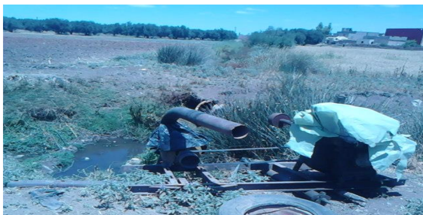
Figure 76 : Irrigation des terrains agricoles par les eaux usées brutes
