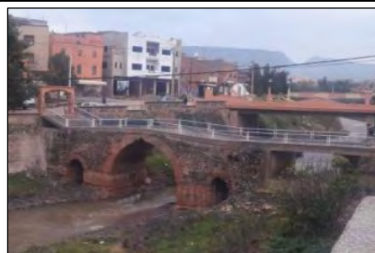
Aménagement non intégré qui dénature le pont Mly Smail
