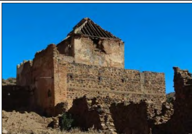
Quelques murailles sont totalement détruites
