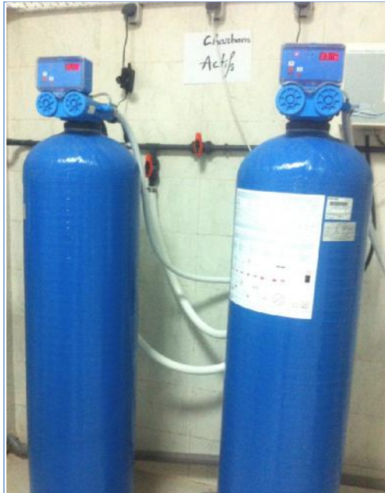
Figure 36 : Deux charbons actifs en aval des adoucisseurs
