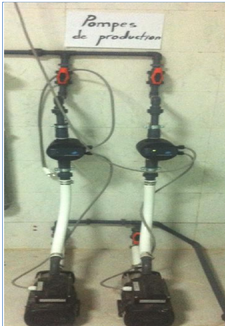
Figure 31 : Pompes de surpression
