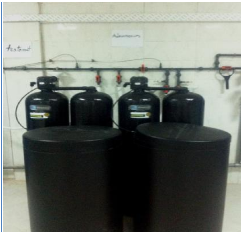
Figure 34: Deux adoucisseurs en parallèle
