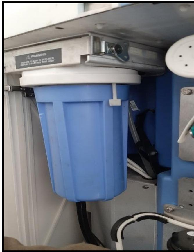
**Figure 17 : Représentation du filtre à charbon actif du système de purification MEDICA**
