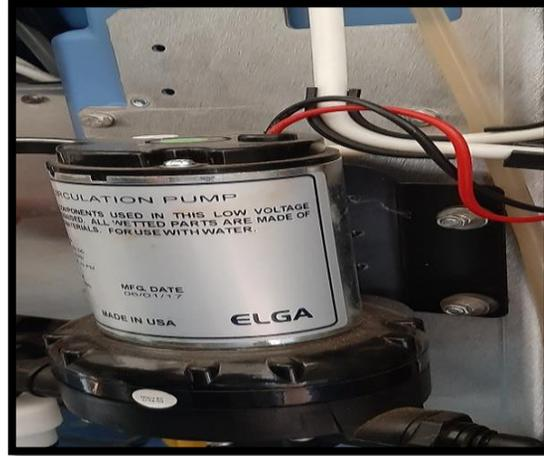
**Figure 24 : Représentation de la pompe de recirculation du système de purification MEDICA.**
