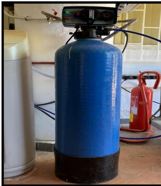
**Figure 13 : Photo représentative du filtre à sable.**
