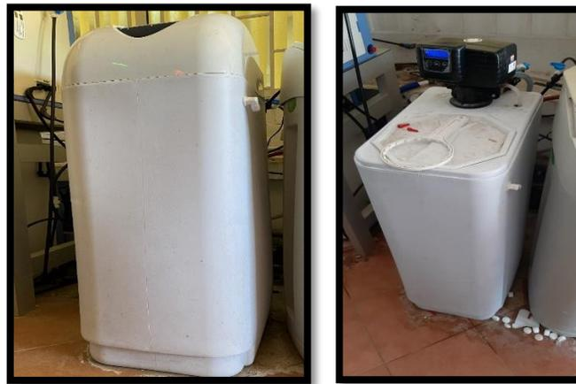
**Figure 14 : Photos représentatives des adoucisseurs de la station de purification de l'eau du LCB.**
