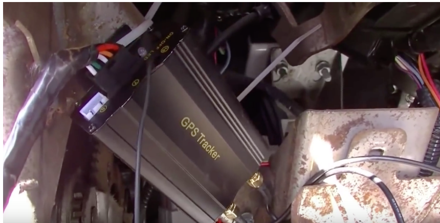
FIGURE 5.1 – Raccordement d'un traceur GPS dans un véhicule.
