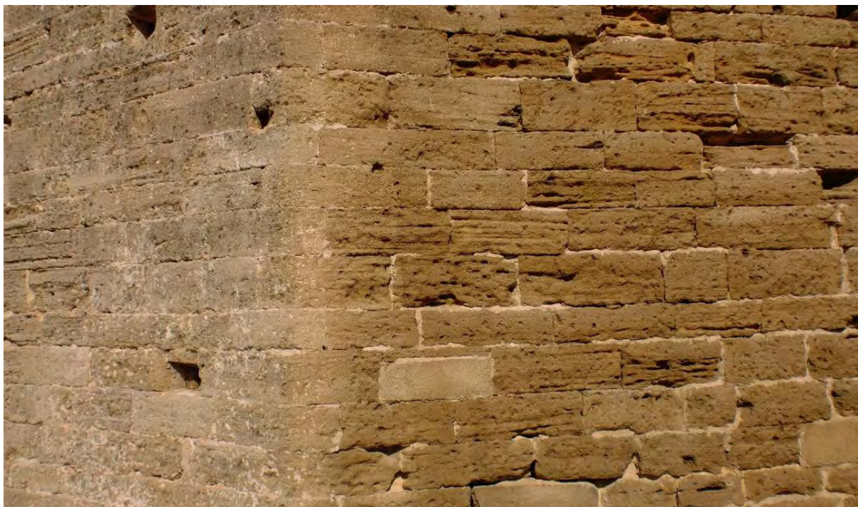
Figure 1.7 – Alvéolisation et désagrégation sableuse de la calcarénite sur les façades des tours du site Oudaya.
