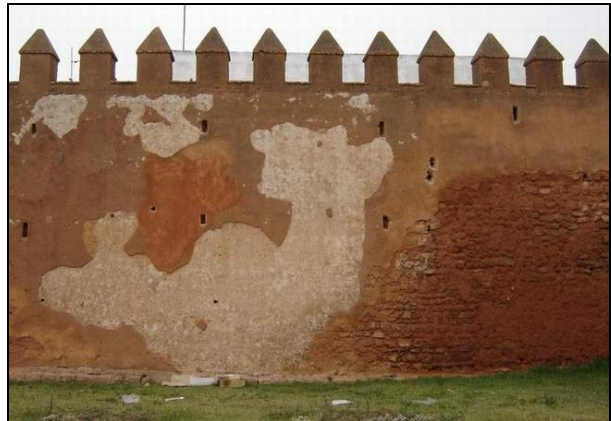
Ph 4.7 Décollement d'enduit de la muraille de Bab Antar (a ; b).
