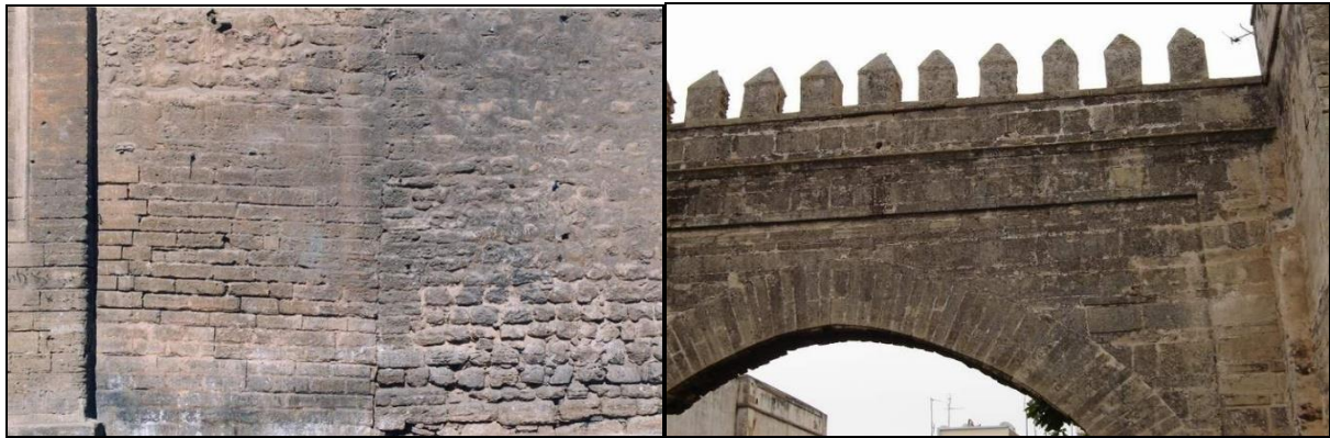
Ph 4.1 Aspects des croûtes noires sur les portes de l'enceinte de Salé (1, 2 Bab Mrisa ; 3 Bab Sebta ; 4. Bab Antar).
