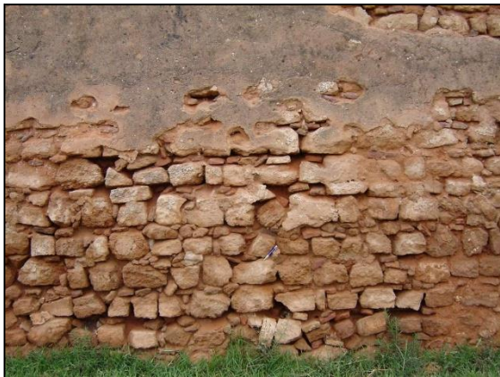
Ph 4.7 Décollement d'enduit de la muraille de Bab Antar (a ; b).
