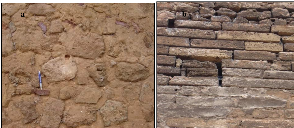
Ph 4.9 Utilisation des matériaux différents des matériaux d'origine (morceaux de briques (a), du ciment (b) et autres).
