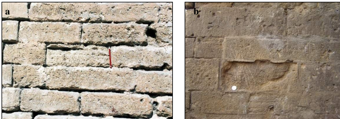
Ph 4.6 Décollement en plaques de la pierre monumentale de Bab Sebta (a) et Bab Mrisa (b).
