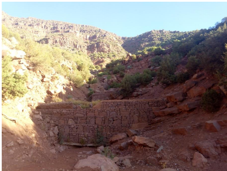
Photo 16 : Aménagement anti-érosif pour correction torrentielle
