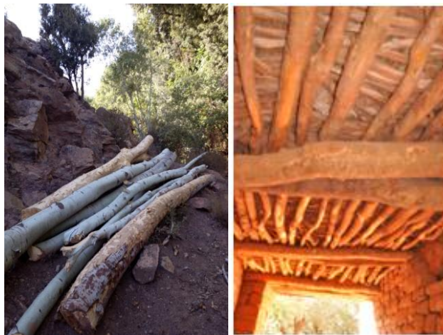
C : Troncs d'arbre taillé en poutre pour la construction de toit de maison
