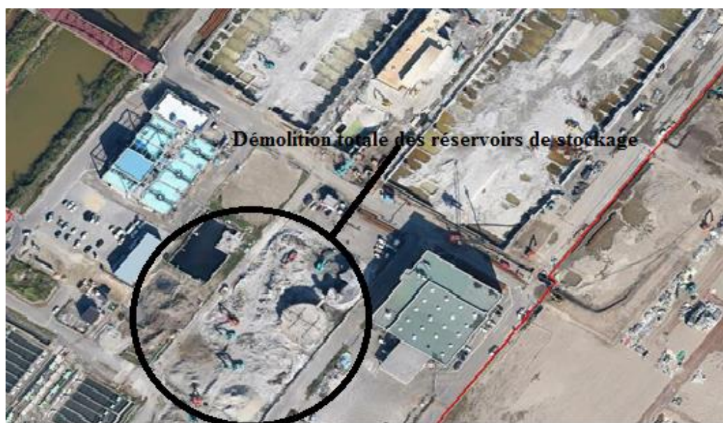
Figure 26: démolition totale de la station de traitement des eaux suite au tsunami d'origine sismique survenu au Japon en 2011 [149]
