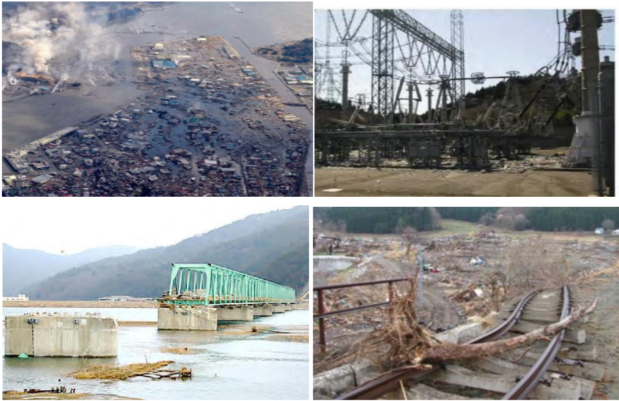
Figure 20: différents types de dommages occasionnés par les vagues tsunamiques. HAZUS2013 [142]
