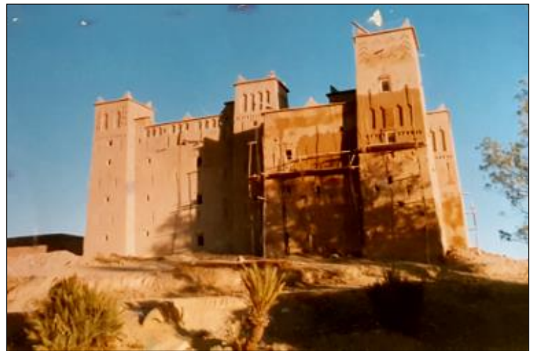
b- Après la restauration
