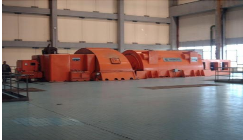
Figure 23: Turbo-alternateur choisi pour l'étude de cas, 75 MW
