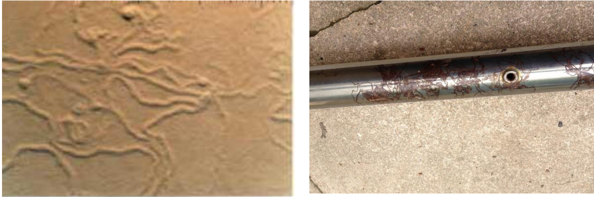
Figure I.16. : Exemples de corrosion filiforme.
