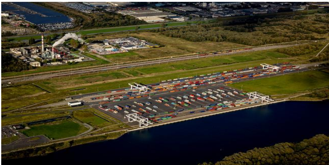
Figure II.14 Vue sur le terminal multimodal du Havre
