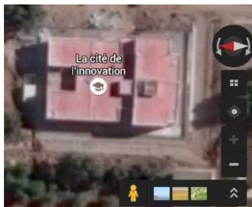
Figure IV-1 : Vue du bâtiment prise par Google Maps.
