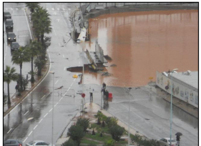
Planche 6 : Inondation Gare Casa port en 30 Novembre 2010
