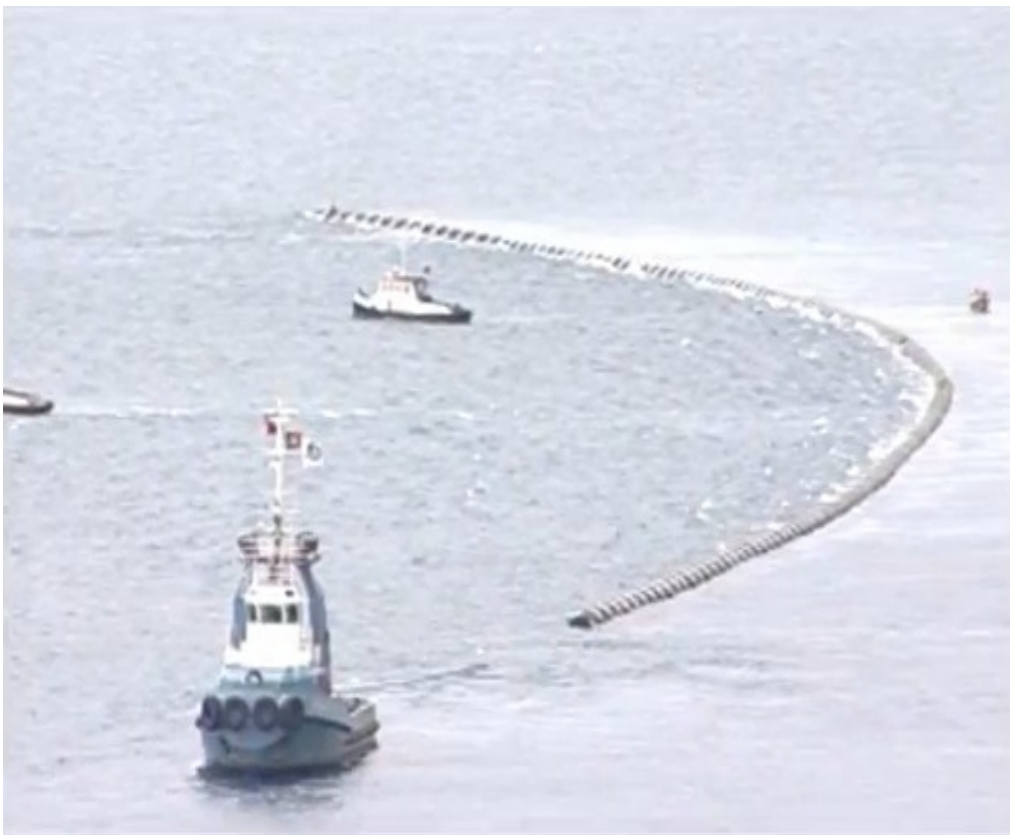
Fig. V.13. Installation de l'émissaire marin de la baie de Tanger
