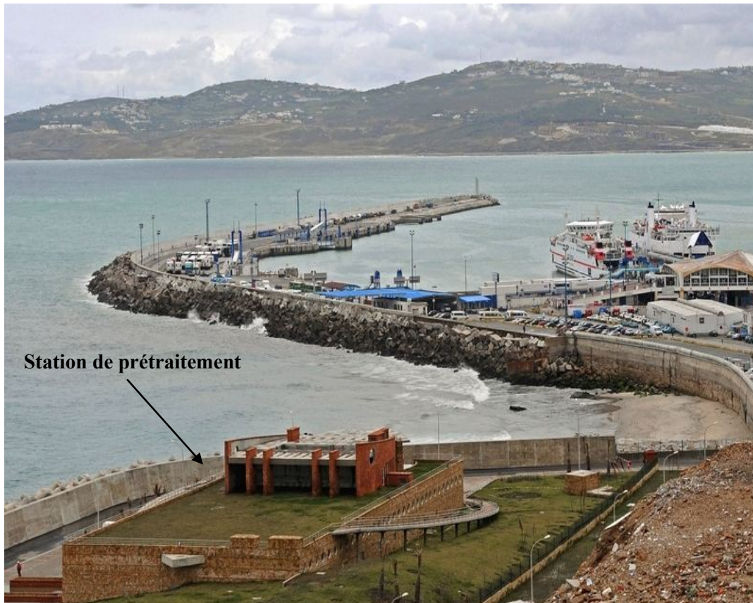
Fig. V.12. Station de prétraitement du port de Tanger
