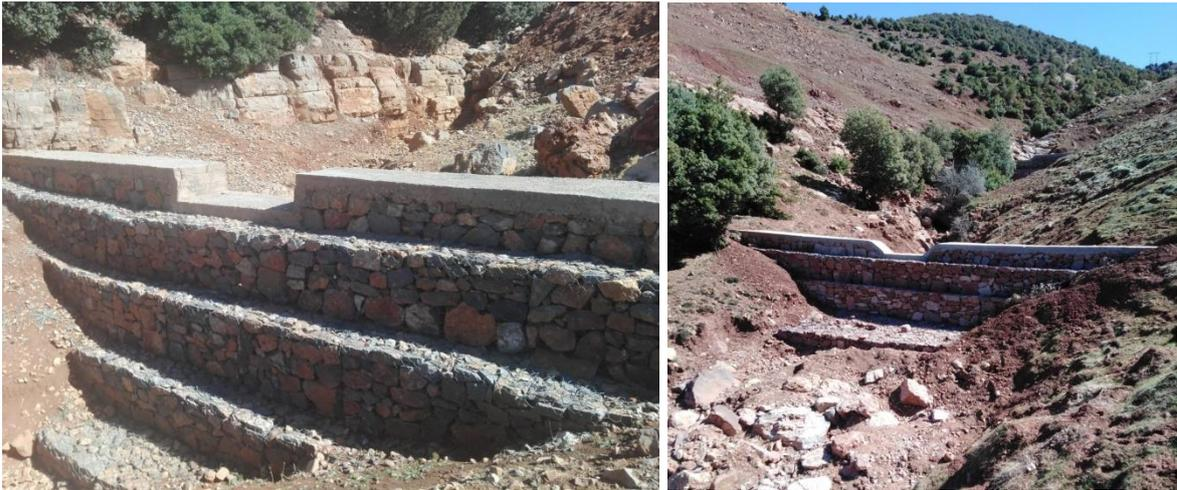
**Photo 14 : Seuils en gabion à l'aval du barrage Bin El Ouidane**
