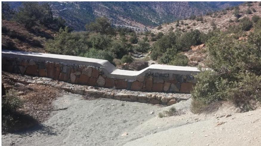
**Photo 15 : Seuil en gabion dans le sous bassin versant oued Ahnçal**
