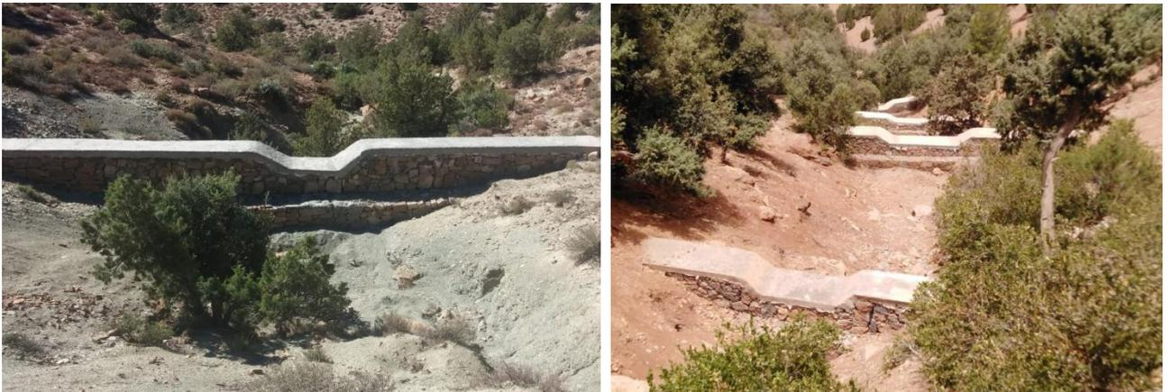
**Photo 20 : Combinaison des corrections mécanique et biologique**
