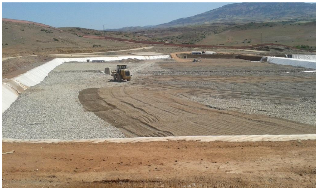
Figure 32: Travaux d'aménagement des casiers de la décharge (Photo prise en 2016)
