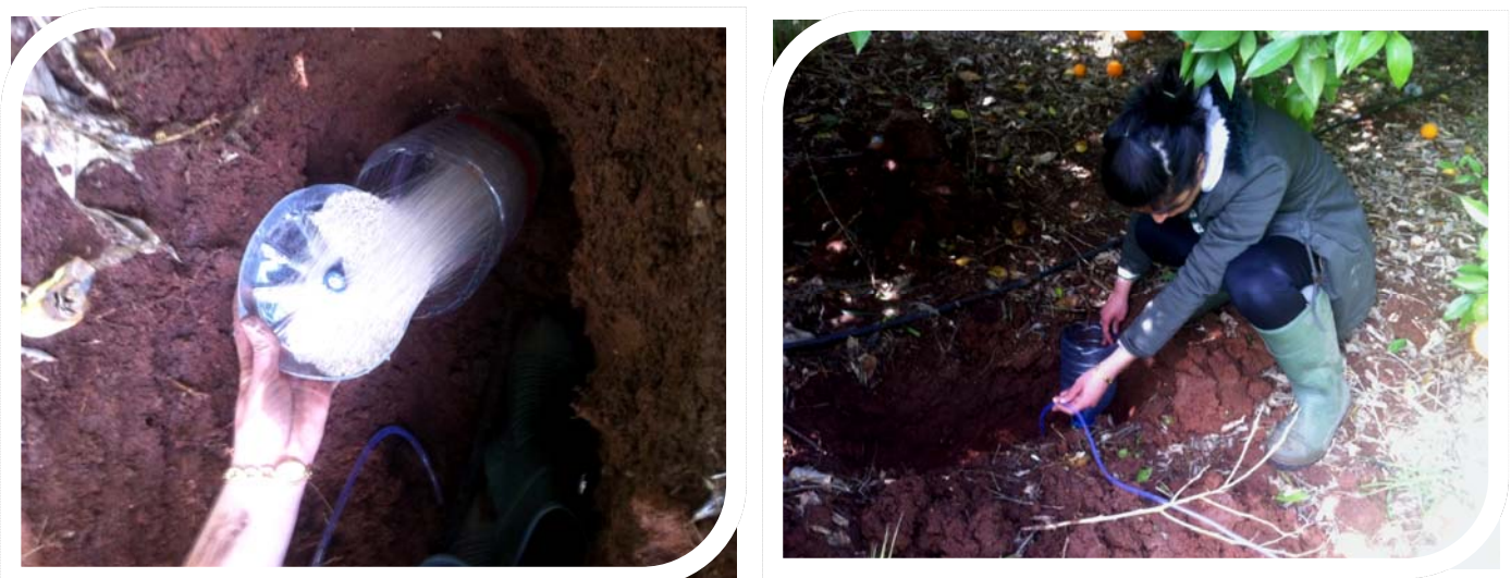
Figure 51: L'installation des lysimètres
