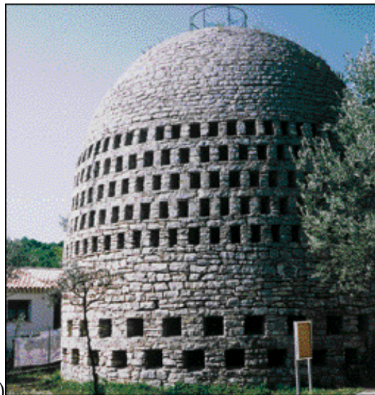
Figure 1. 9. Photos des anciens condenseurs passifs: a) Le condenseur de Zibold à Féodosia (Crimée, Ukraine) et b) le condenseur de A. Knapen à Trans-en-Provence (France) dans son état actuel (Lekouch, 2010).
