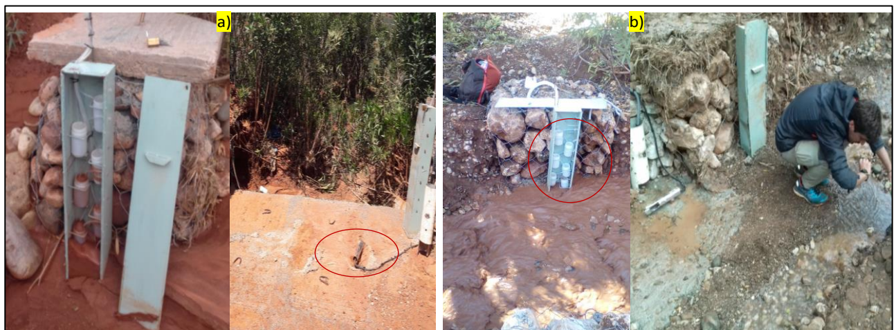
Photos 4: les turbidimètres et les échantillonneurs installés aux exutoires des deux bassins expérimentaux de Talhiant (a) et Mougeryberdan (b)
