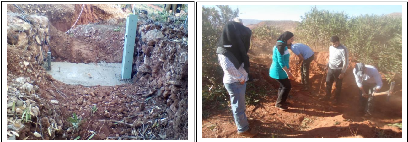
Photos 6: Préparation des sections en aval des deux sous-bassins expérimentaux 2017.
