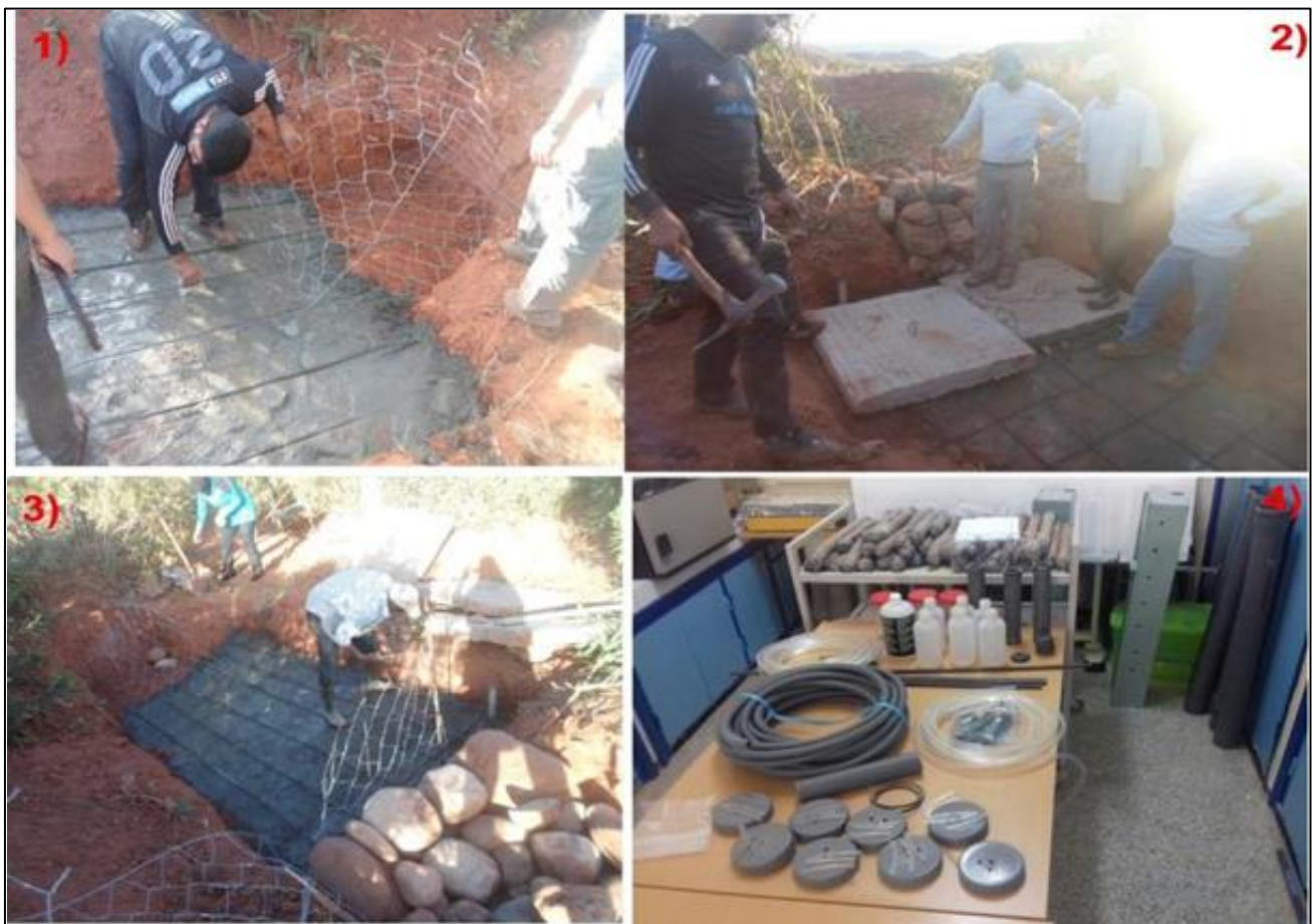
Planche de photos 9: Préparations des sections à l'exutoire du deux bassins expérimentaux (1,2,3) et préparations du matérielles pour la fixation sur terrain. Source : photos prise en 2017.
