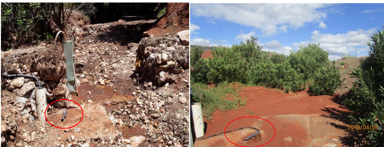
Photos 8: Capteur de turbidité (turbidimètre) installé en 2018.
