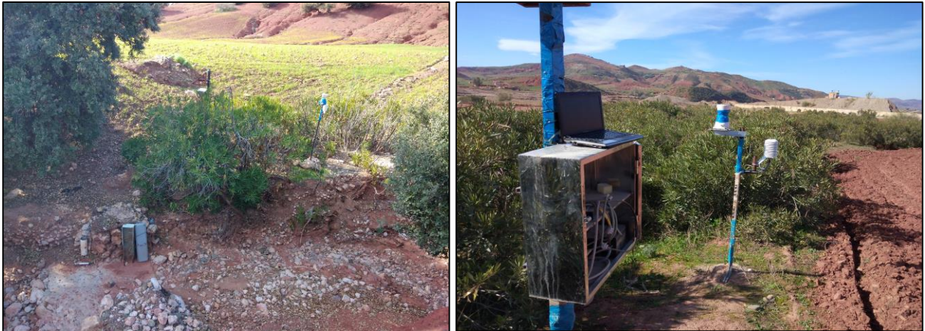
Photos 7: Les deux stations de jaugeages installées dans les deux bassins versants expérimentaux en 2017- 2020
