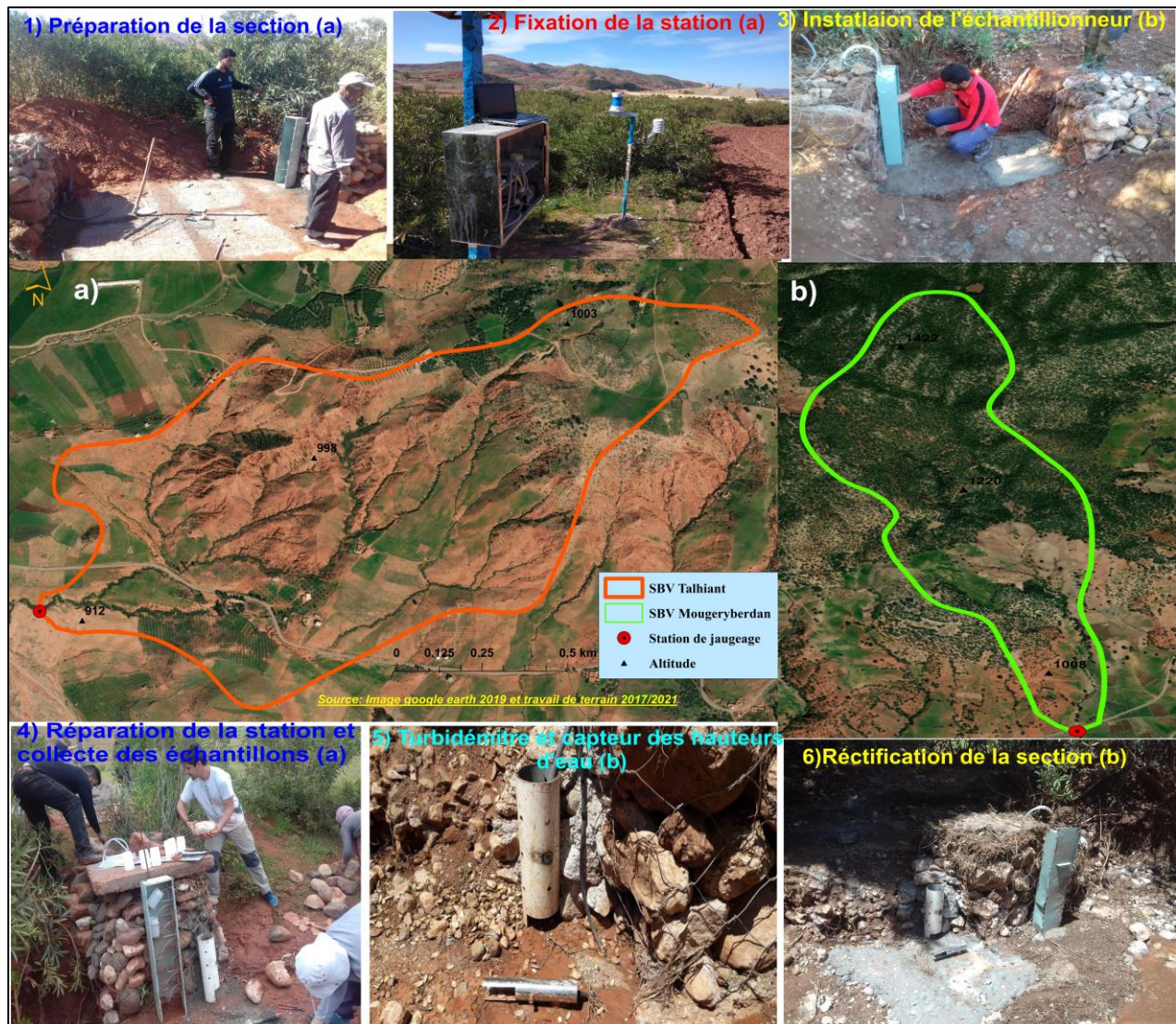
Figure 4: Installation et équipement des exutoires des bassins expérimentaux de Talhiant (a) et Mougeryberdan (b) 2017/2020.
