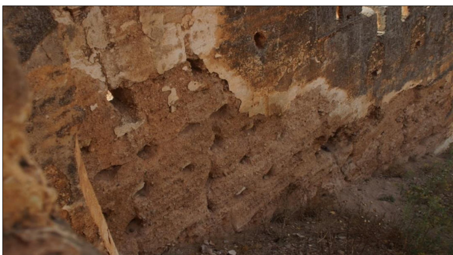
Photo 20 : partie inférieure du tronçon Ouest de la quasba ismailia (source auteur)
