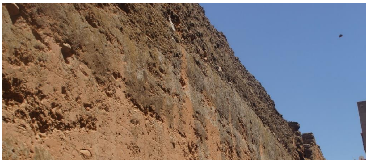
Photo 14 : partie supérieure du tronçon Est muraille de Demnate (source auteur)
