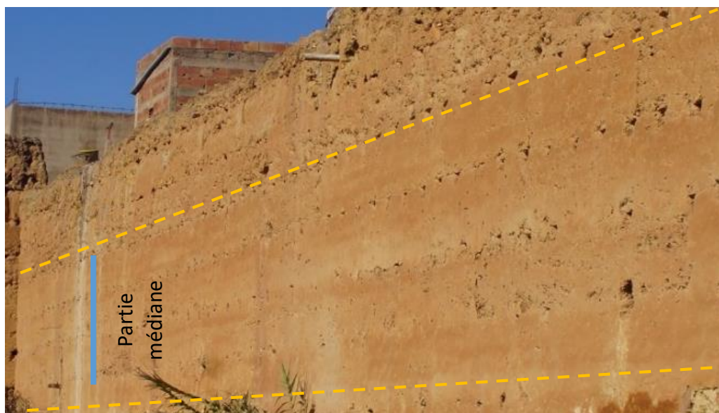
Photo 16 : partie médiane du tronçon Sud muraille de Demnate (source auteur)
