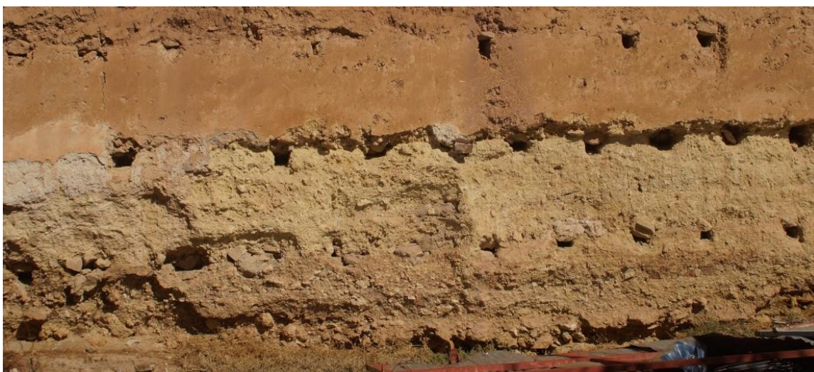
Photo 15 : partie inférieure du tronçon Sud muraille de Demnate (source auteur)
