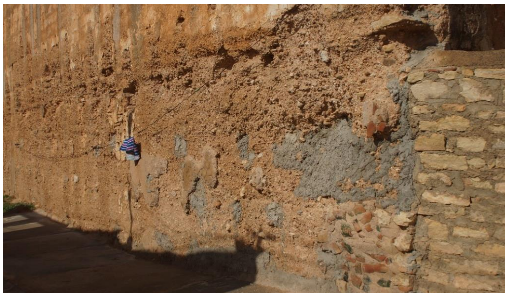
Photo 23 : partie inférieure du tronçon Sud de la Kasabah Ismaïlia (source auteur)
