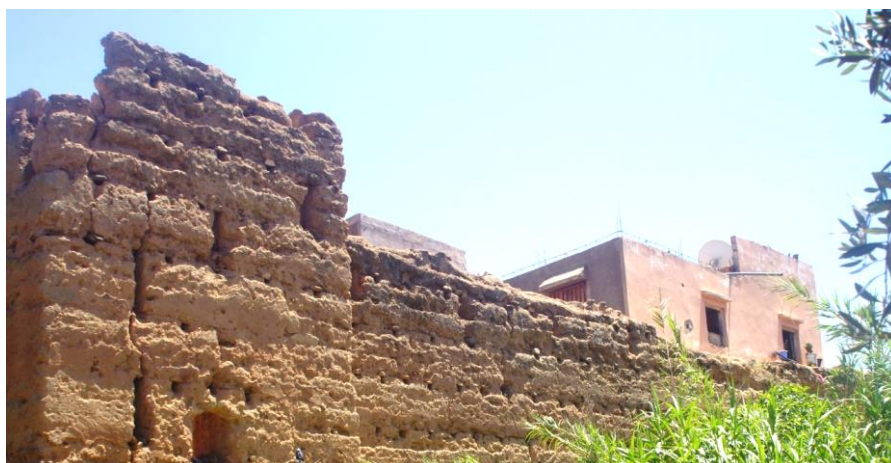
Photo 11 : partie supérieure du tronçon Ouest muraille de Demnate
