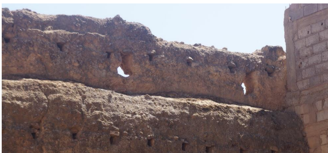
Photo 17 : partie supérieure du tronçon Sud muraille de Demnate (source auteur)
